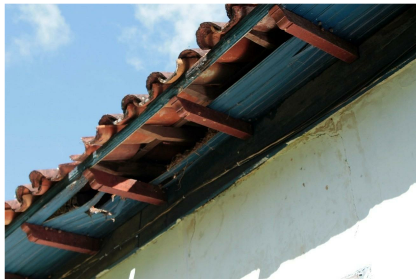
Vista de parte do beiral da lateral leste da casa sede com perda do forro em madeira lambri comprometida, falha no manto de cobertura com ausência de telhas e presença de umidade sob o coroamento demonstrado em retângulo em vermelho. – Fazenda Boa Esperança. Foto: SECULT - Brenda Souza, 16/03/2022.
