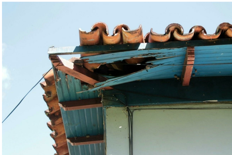
Foto acima de parte do beiral da lateral leste da casa sede com perda pontual do forro em madeira lambri– Fazenda Boa Esperança. Parte do manto da cozinha com ausência de telha, fiação exposta demonstrado em seta vermelha. Foto: SECULT - Brenda Souza, 16/03/2022.
