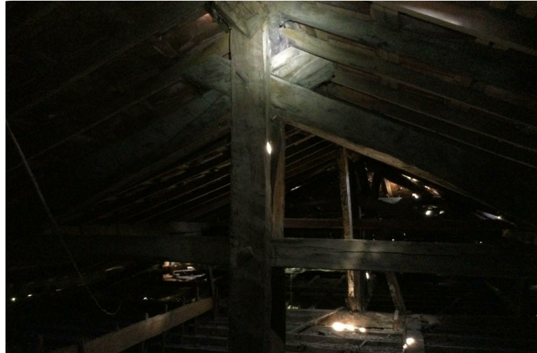
Vista parcial interna da estrutura da cobertura – Fazenda Boa Esperança. Estrutura de madeira angelim ,canela e paraju. Visível deslocamento de telhas, demonstrado pela entrada de luz no local podendo ser visualizado através de elipse pontilhada em vermelho. Foto: SECULT 16/03/2022.
