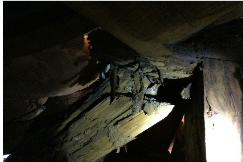
Vista interna da parte da estrutura da cobertura, tesoura com junção da cumeeira– Fazenda Boa Esperança, com desgaste dos encaixes, apodrecimentos, fissuração nas peças e ataques de insetos xilófagos. Foto: SECULT 16/03/2022.
